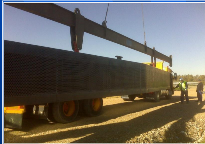
Módulos de ataguía para aislar cada vano.
