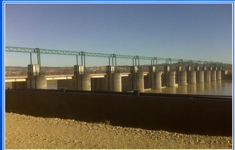
Estructura metálica como guía del polipasto.
